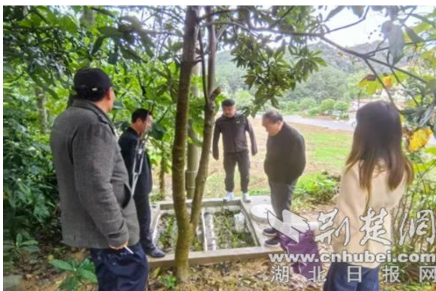
曹兴国（左三）在农场污水处理池建设现场查看施工进度
