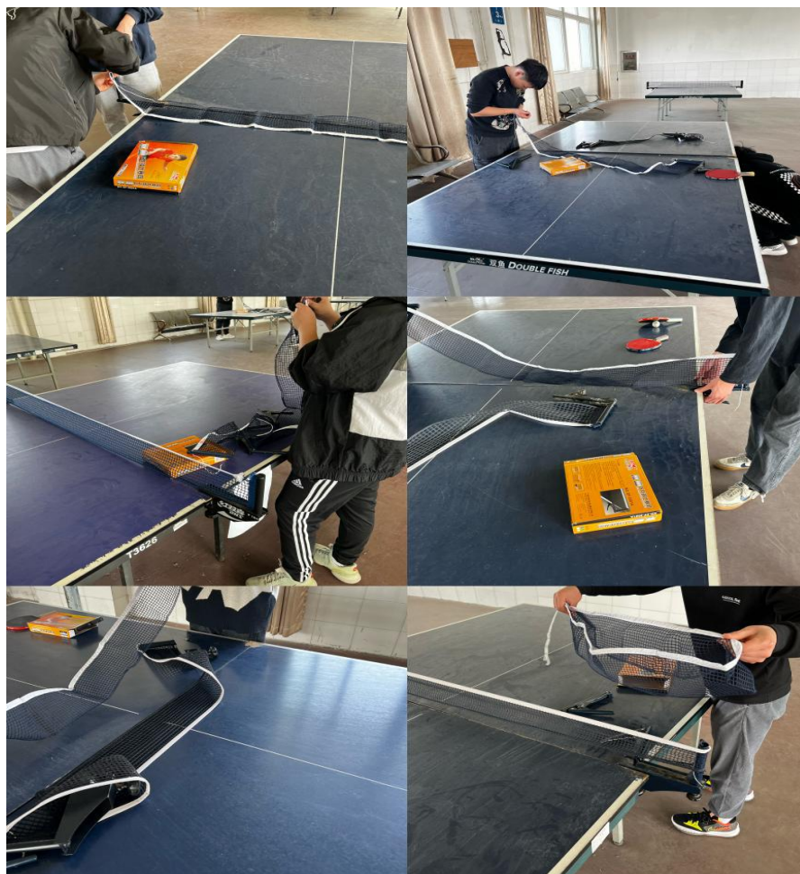
体育学院开展“更换晨光乒乓球馆球网柱”劳动项目
